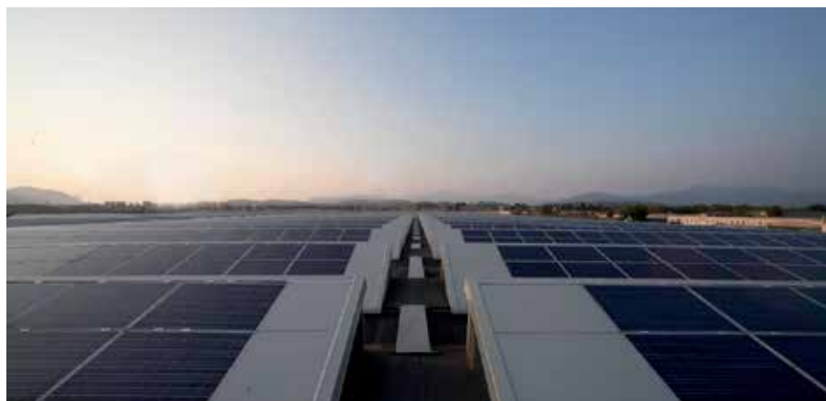
Techos fotovoltaicos de la Compañía
